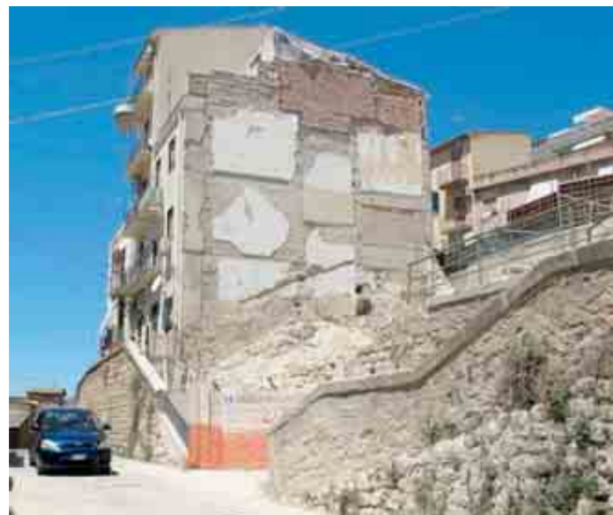
LA ZONA DI VIA REDENTORE DOVE È STATO DEMOLITO L'EDIFICIO PERICOLANTE
